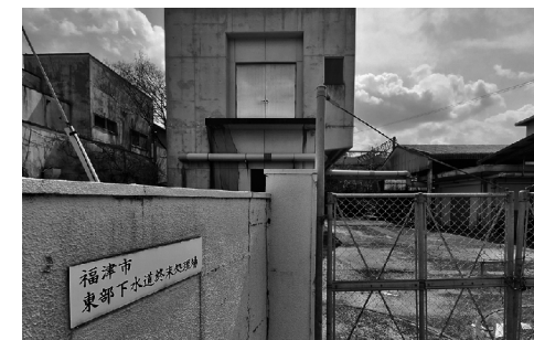
規模は所沢の約10分の1、駅に隣接した東部下水処理場
